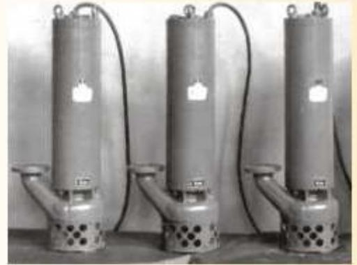
Bereits Mitte der 30er Jahre des vergangenen Jahrhunderts entwickelte **oddesse** sowohl einstufige Tauchmotorpumpen (Schmutzwasserpumpen) als auch mehrstufige Tauchmotorpumpen (Unterwassermotorpumpen) und deren wassergefüllte Spezialmotoren.
